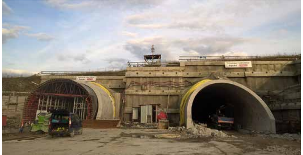
Portál tunela Žilina
