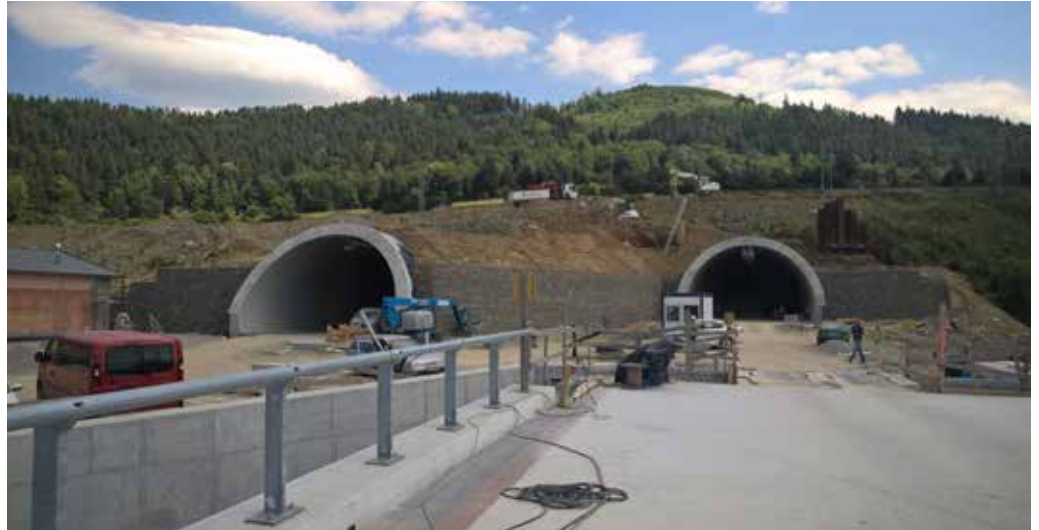
Tunel Považský Chlmec západný portál
