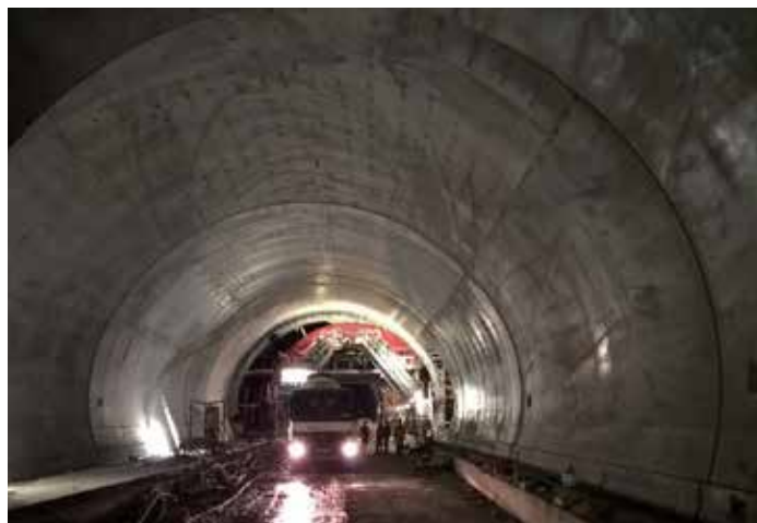
Betonáž sekundárneho ostenia
