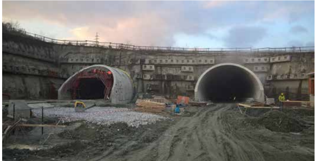
Tunel Ovčiarsko východný portál
