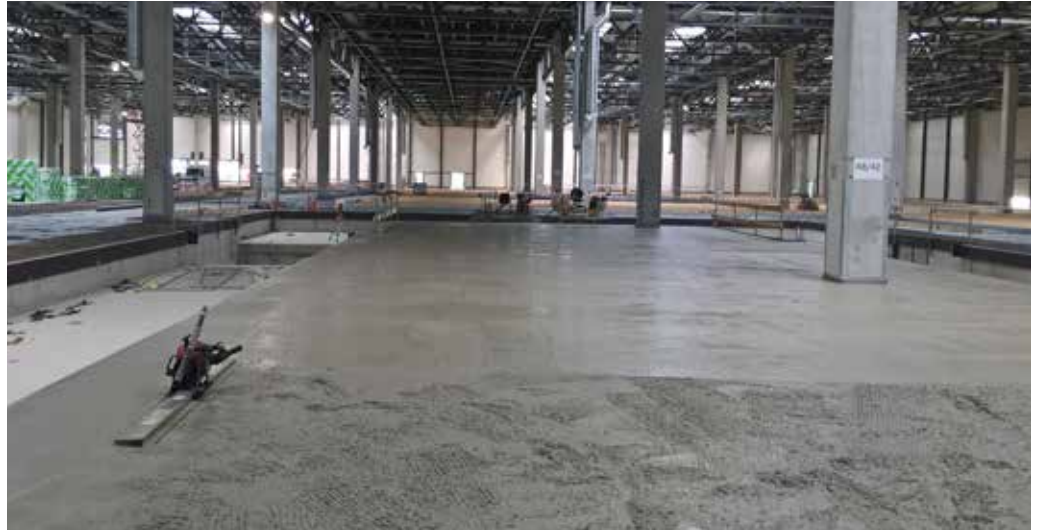
Betonáž podlahových konštrukcií
