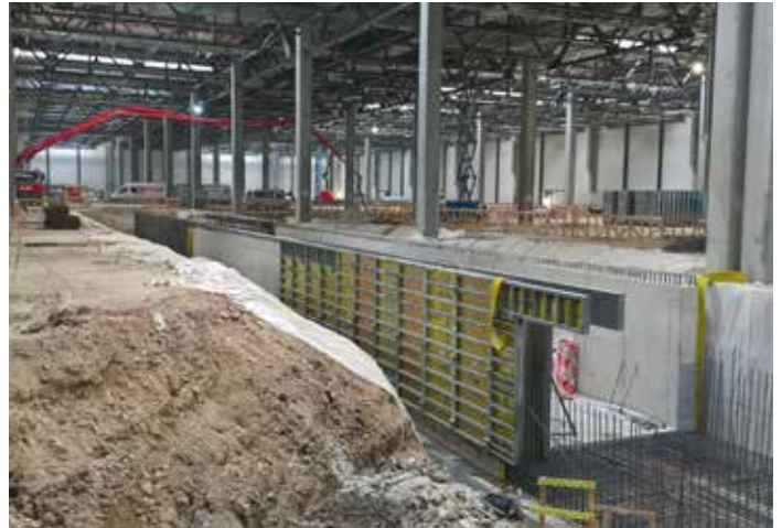
Betonáže iných koštručných častí
