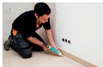
Заполнение швов пола и стен герметиком PCI Silcoferm S не сопровождается неприятным запахом в процессе работы и после её завершения.
