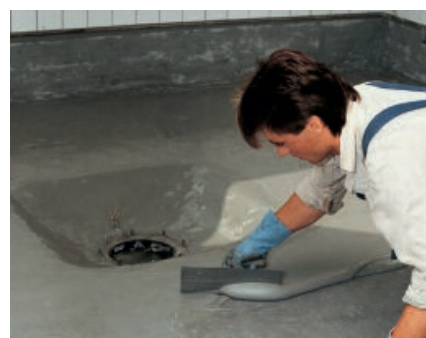
Применение PCI Apoflex F для гидроизоляции под керамической плиткой на кухнях предприятий общественного питания
