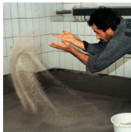
... а затем присыпать новое покрытие кварцевым песком (размер частиц 0,3–0,8 мм).
