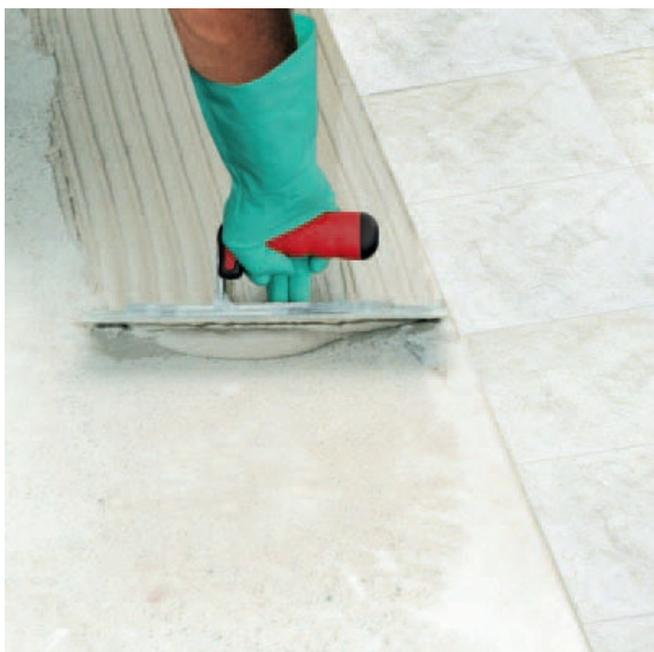
PCI Carrament пластичный, удобный в применении раствор для укладки плит средним слоем.
