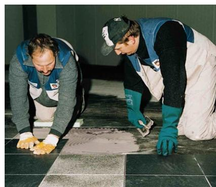
Надежная укладка плит из натурального камня средним слоем с помощью PCI Carrament<sup>®</sup>
