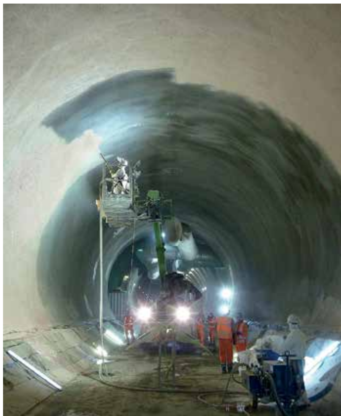
Нанесение гидроизоляционной мембраны MasterSeal 345
