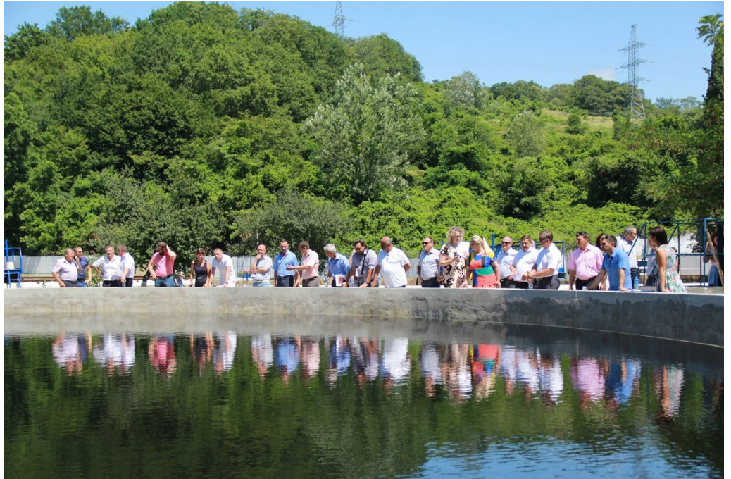
Объект комплекс очистных сооружений ООО Сочиводоканал в мкр. Кудепста., г. Сочи
