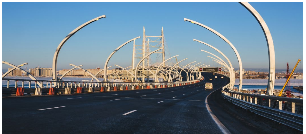
Объект: Западный скоростной диаметр, г. Санкт-Петербург
