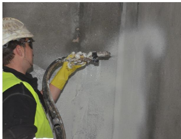
Нанесение состава MasterSeal P 385 пневматическим распылителем
