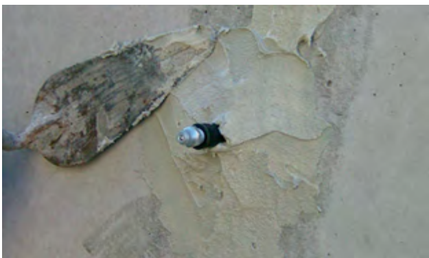
Rys. 2. Uszczelnienie iniektorów naklejanych przy użyciu MasterFlow 920 AN.
