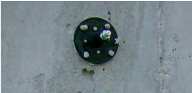
Rysunek 1. Umieszczenie pakera klejonego na powierzchni rysy.
