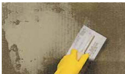
2. Påfør MasterBrace F2000 med en murskje eller sparkelkniv for å glatte ut ujevne overflater.
