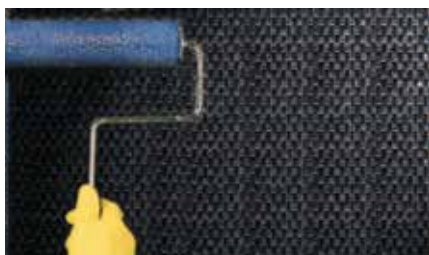
5. Legg det tørre stoffet i våt metningsharpiks og press ned på overflaten ved hjelp av en piggrulle. Påfør et nytt lag med metningsharpiks for å innkapsle fibre helt. Gjenta lagene med metningsharpiks/fiber/metningsharpiks etter behov.
