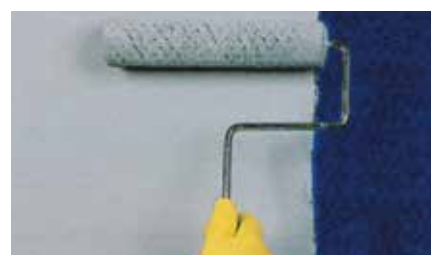
6. Påfør toppbelegg dersom det kreves.
