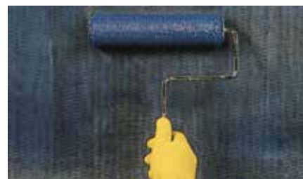
3. Påfør et lag MasterBrace SAT 4500 eller 4700 med en myk 10 cm-rulle.
