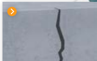
Reparasjoner av undersider samt vertikalt og horisontalt
