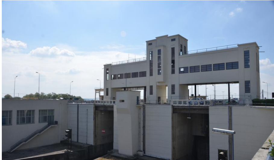
Onze referentie in Lannaye (Belgium): Sluizencomplex Lannaye
