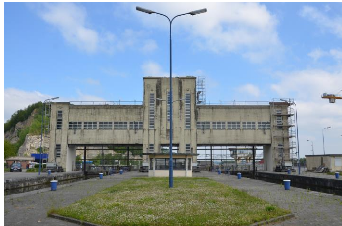
Onze referentie in Lannaye (België): sluizencomplex Lannaye
