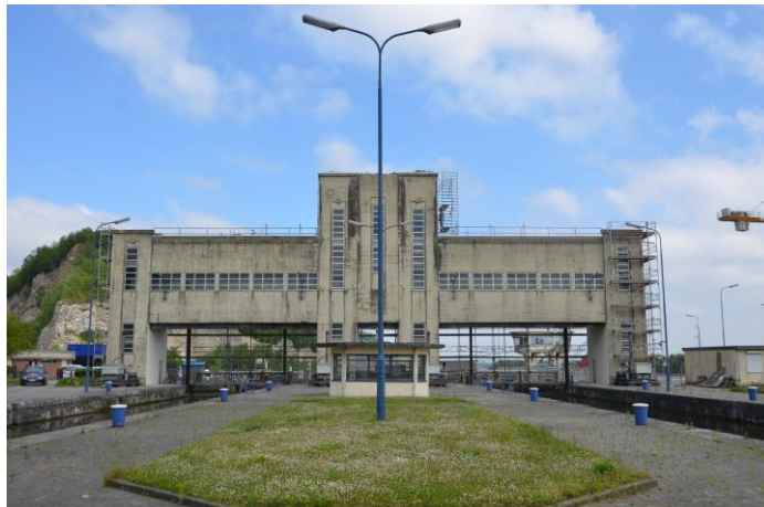
Onze referentie in Lanaye (België): sluizencomplex Lanaye
