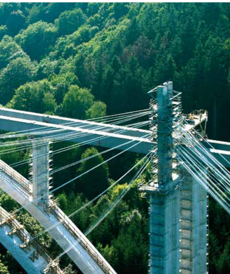
La nostra referenza a Dohna (Germania): Il ponte Seidewitztal sull'autostrada A17
