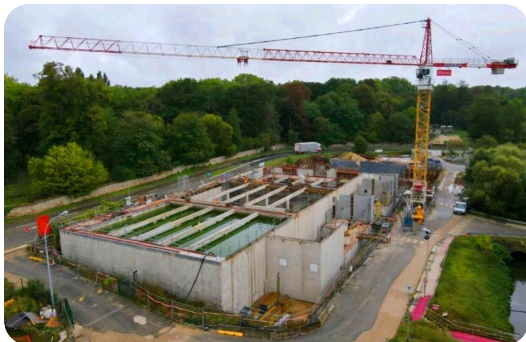
Chantier de la station d'épuration de Gazeran
