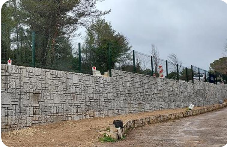
Mur de soutènement en blocs de béton armé de MasterFiber 236
