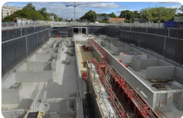
Chantier de la ligne B du métro de Rennes
