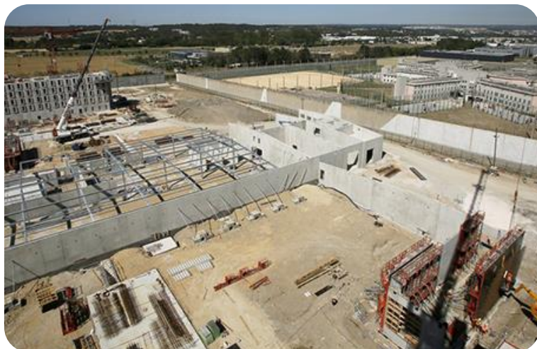
Chantier du centre pénitentiaire d'Aix-Luynes
