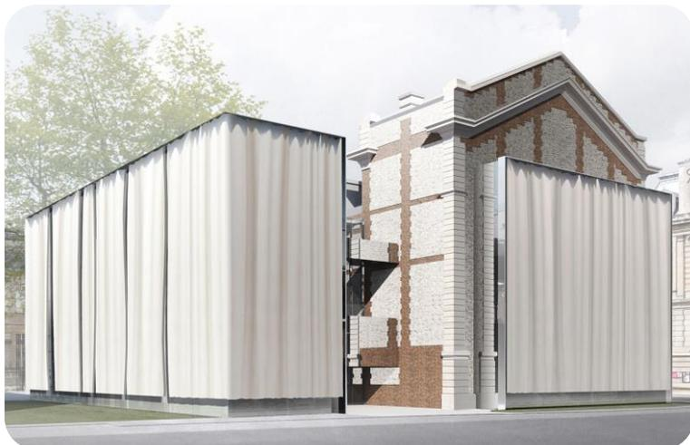
Panneaux ondulés en béton fibré stimulant le mouvement du rideau
