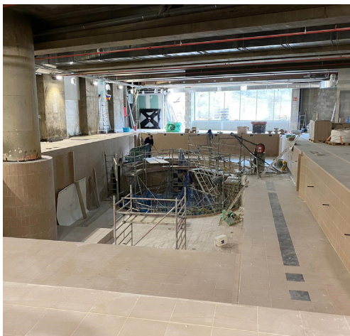
Vista del proceso de ejecución de los trabajos de impermeabilización y acabado de la sima y del vaso y playa de acceso
