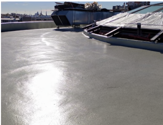
Vista de la cubierta antes y después de la actuación de impermeabilización con MasterSeal Roof 2111
