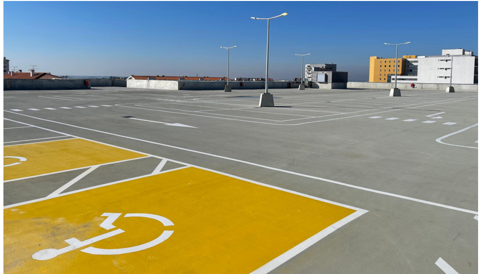
Aspecto final de la cubierta impermeabilizada mediante el Sistema MasterSeal Traffic 2689.
