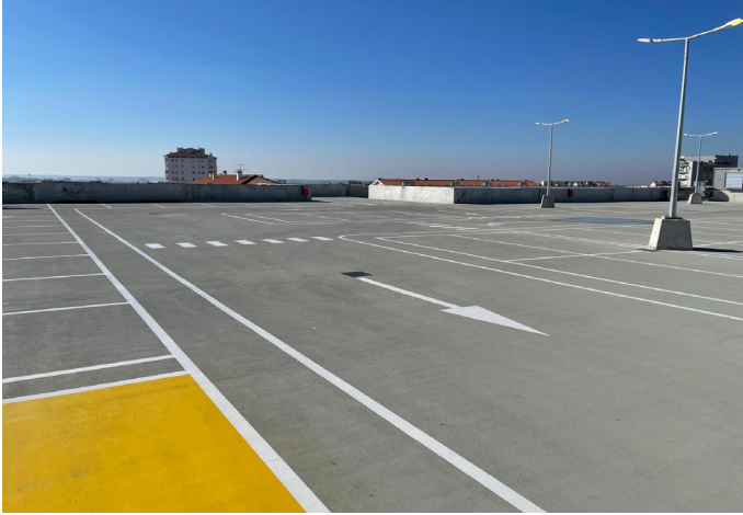
Sistema MasterSeal Traffic 2689 para impermeabilización de cubiertas de parking Glicinias Plaza Shopping Center.
