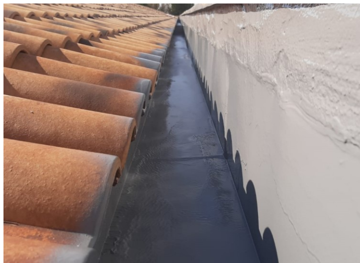
Trabajos de proyección de la membrana MasterSeal M 811 en la cubierta y acabado final.
