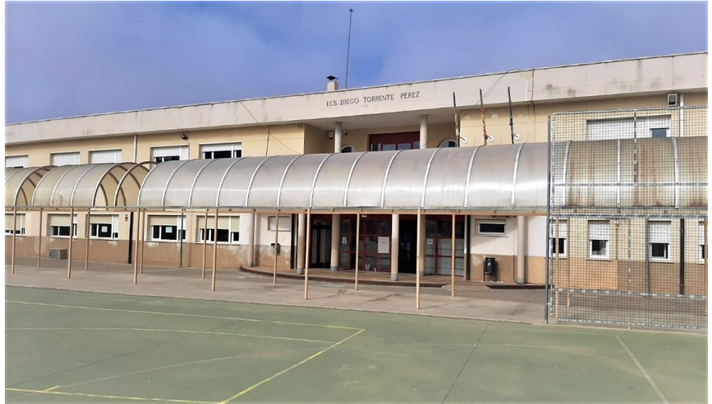
Centro de Educación Secundaria Diego Torrente Pérez – Sistema MasterSeal Roof 2111.
