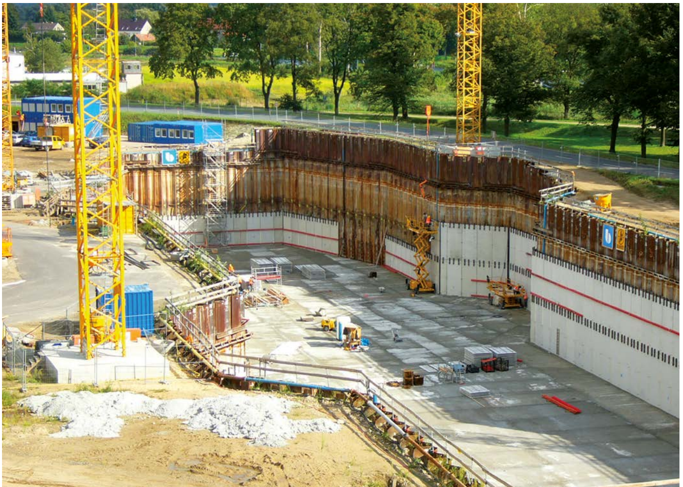
Unsere Referenz in Niederfinow (Deutschland): Fundamente des Schiffshebewerkes
