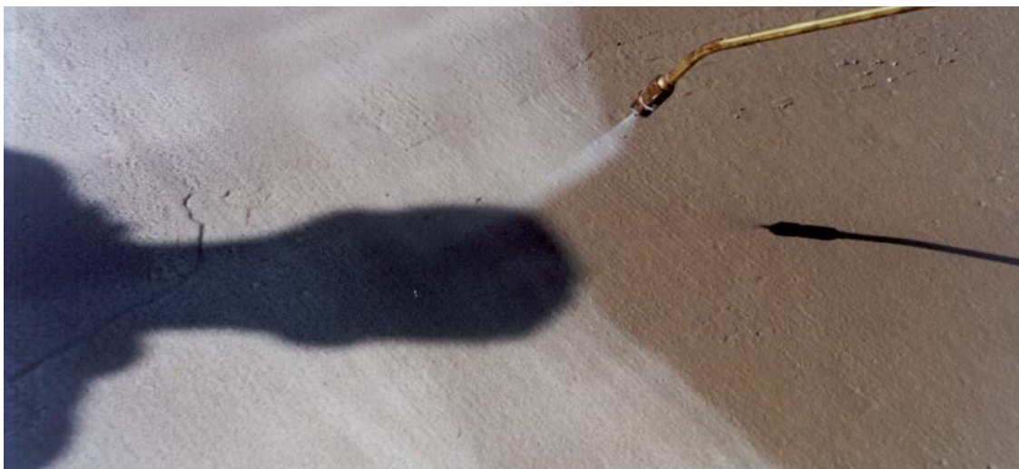
Anwendung von MasterKure auf der Baustelle unmittelbar nach dem Betoneinbau
