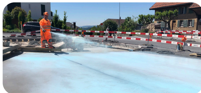
Herstellung von Waschbeton (schematisch)
