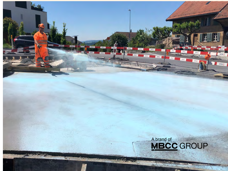
Herstellung von Waschbeton (schematisch)
