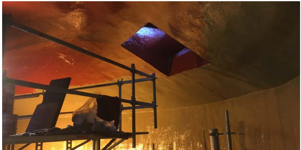
Rådnetanken renoveres med MasterSeal 7000 CR
