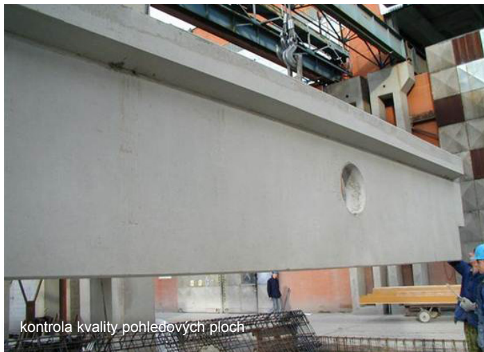
Nové vývojové centrum ŠKODA AUTO a.s., Praha (CZ): Předpjaté vazníky ze samozhutnitelného betonu o délce 20 m
