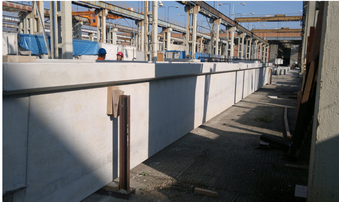
Naše reference v Praze (CZ): Předpjaté vazníky ze samozhutnitelného betonu o délce 20 m
