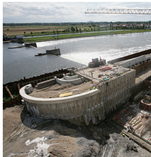
Stavba malé vodní elektrárny, Litoměřice (CZ): náročná betonáž savky, bez hutnění, s dokonalým povrchem hotového díla
