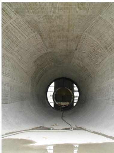
Stavba malé vodní elektrárny, Litoměřice (CZ): náročná betonáž savky, bez hutnění, s dokonalým povrchem hotového díla
