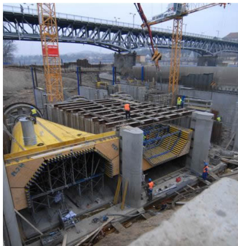
Stavba malé vodní elektrárny, Litoměřice (CZ): náročná betonáž savky, bez hutnění, s dokonalým povrchem hotového díla
