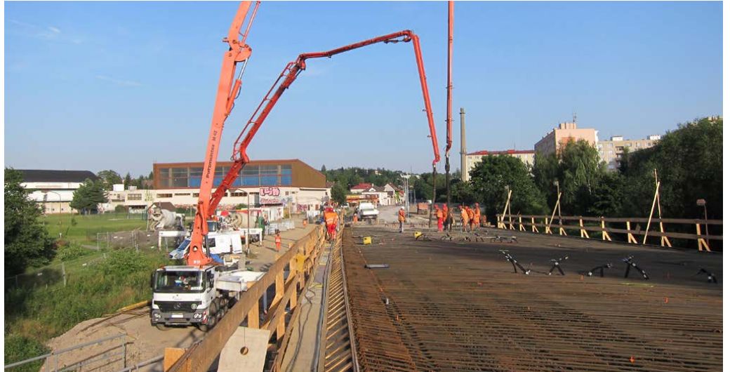
Naše reference ve Žďáru nad Sázavou (CZ): Třípolový betonový most – zajištění plynulé dodávky betonu v krátkém čase
