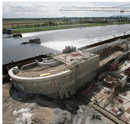
Stavba Malé vodní elektrárny, Litoměřice (CZ): Náročná betonáž savky, bez hutnění, s dokonalým povrchem hotového díla
