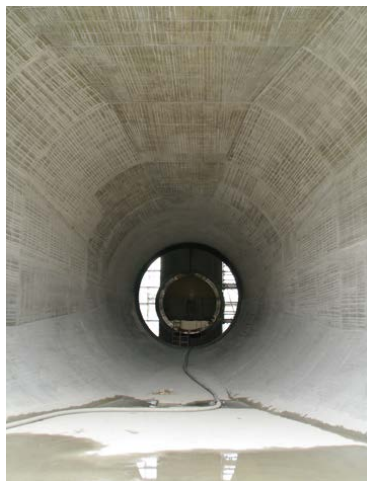
Stavba Malé vodní elektrárny, Litoměřice (CZ): Náročná betonáž savky, bez hutnění, s dokonalým povrchem hotového díla
